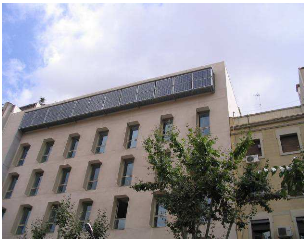
Instalación fotovoltaica 10 kW en cubierta y fachada traslúcida. Centro Asistencia Primaria- Barcelona
