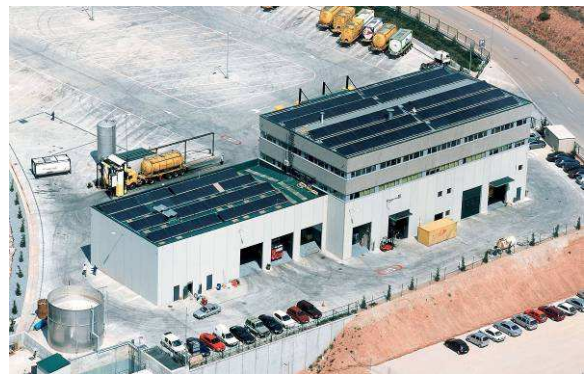
Instalación galardonada con el premio Eurosolar 200
